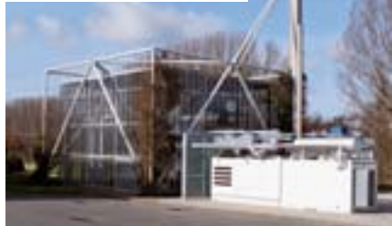
Seit 2008 ergänzt ein CO 2 -neutrales Blockheizkraftwerk mit Kraft-Wärmekopplung die Energiezentrale. | A carbon-neutral cogeneration unit was installed in 2008 to supplement the existing power and heating installations.
